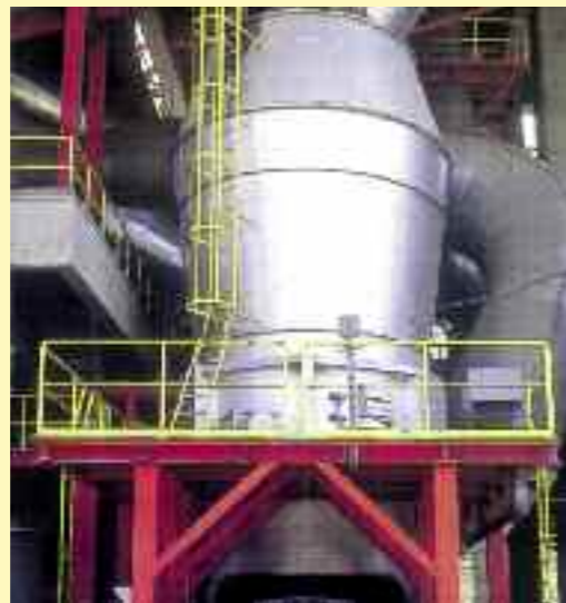
BROYEUR CHARBON VERTICAL
